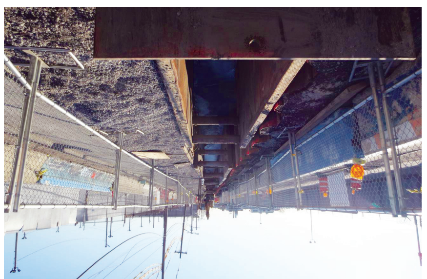
Ułożone przewody i stężenia w ramach przygotowań do zainstalowania nowej kanalizacji burzowej
