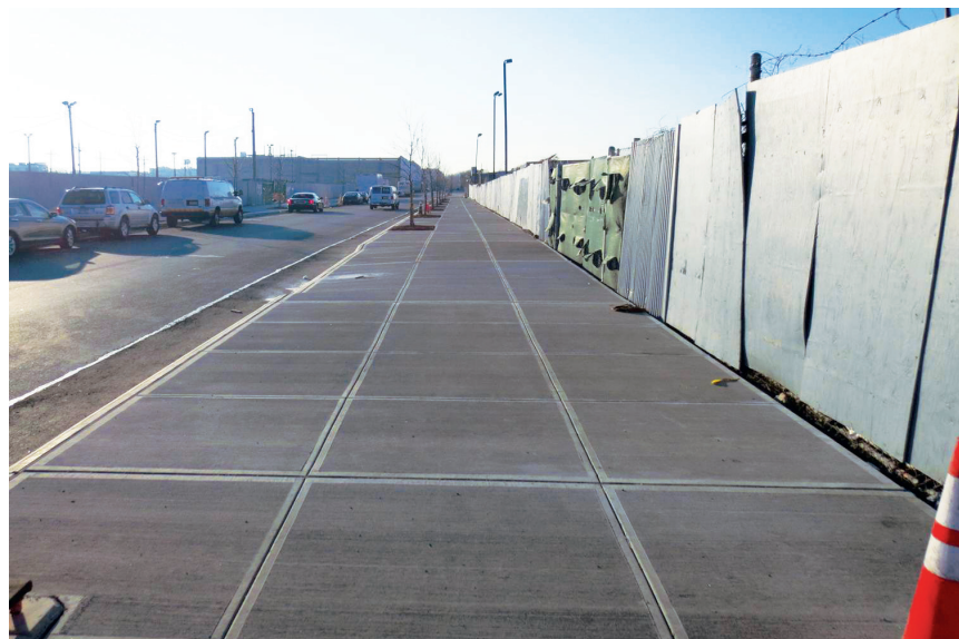
Widok wzdłuż nowego chodnika przy ulicy Monitor
