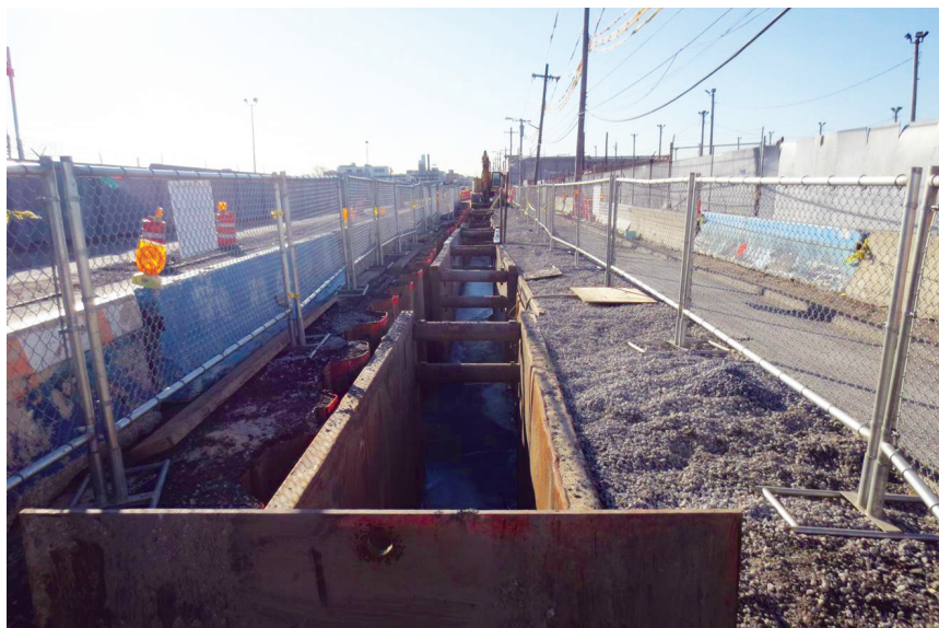
Ułożone przewody i stężenia w ramach przygotowań do zainstalowania nowej kanalizacji burzowej
