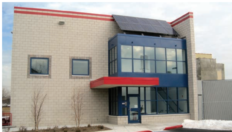
Panele słoneczne na budynku SVE Firma ExxonMobil wykorzystuje panele słoneczne na swojej nowej placówce, gdzie stosowana jest ekstrakcja par z gleby (ang. Soil Vapor Extraction), co pozwala jej wyprodukować energię o mocy 30 000 watów, wystarczającą na pokrycie zapotrzebowania na energię na całej powierzchni biurowej.
