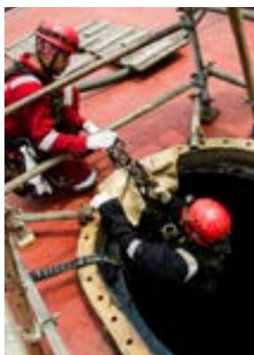
Pendant un cycle quinquennal, les 27 réservoirs de stockage de pétrole et les deux réservoirs de stockage d'eau de ballast du terminal flottant de stockage et de déchargement (FSO) sont soumis à une inspection interne minutieuse et de proximité. Une équipe hautement qualifiée de spécialistes en accès par cordes engagée procède à cette inspection, qui est
