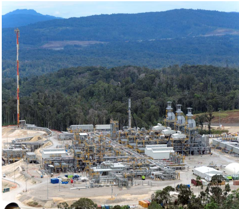
PNG LNG, Hides Gas Plant
